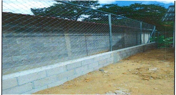
Foto 2: Mejoramieneto de muro de Contención
