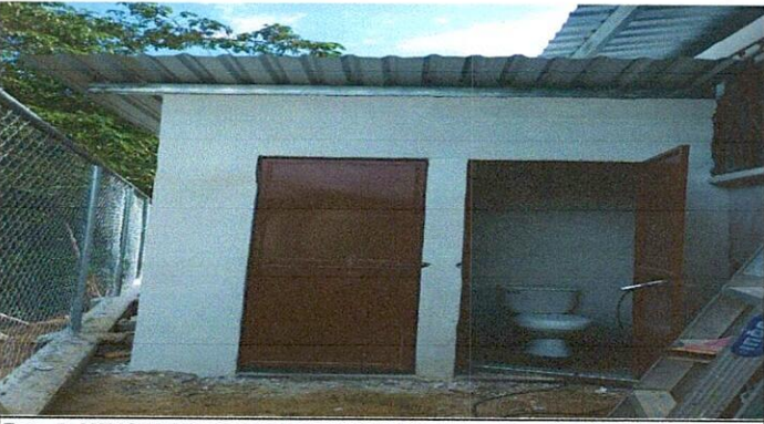
Foto 5: MEJORAMIENTO DE SANITARIOS
