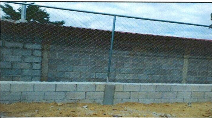
Foto 3: Mejoramieneto de muro de Contención
