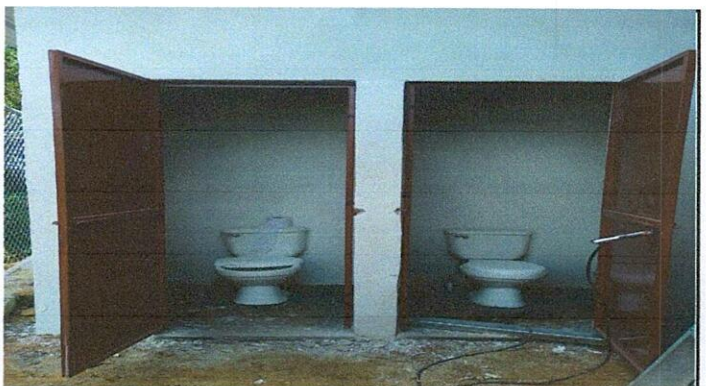
Foto 4: MEJORAMIENTO DE SANITARIOS
